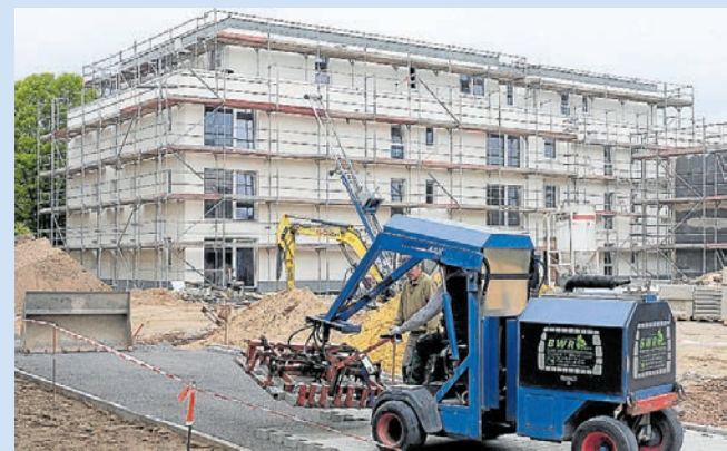
Die Fertigstellung des ersten Gebäudes steht bereits unmittelbar bevor. Mit der kompletten Fertigstellung wird mit März 2020 gerechnet.
